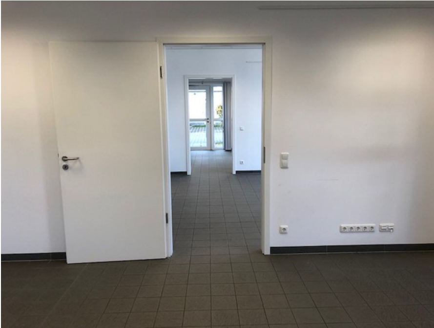
Ansicht Büro, Besprechung , Büro
