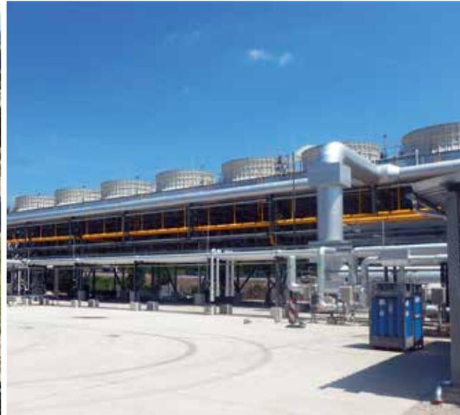
Die Luftkondensatoren, die das Betriebsmedium des Kraftwerks rückkühlen
